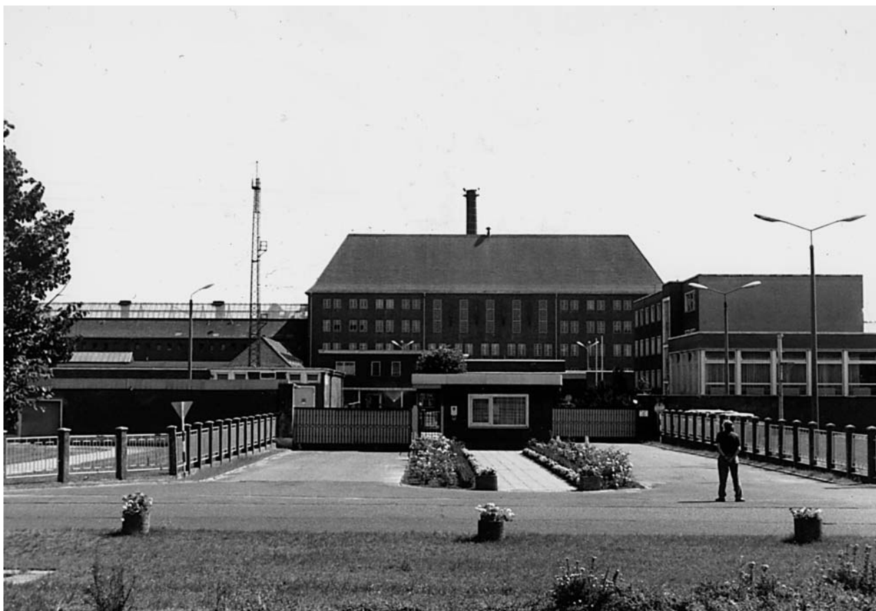
Justizvollzugsanstalt Brandenburg-Görden; im Inneren Dokumentationsstelle Zuchthaus Brandenburg mit Gedenkräumen für die Opfer der NS-Justiz
